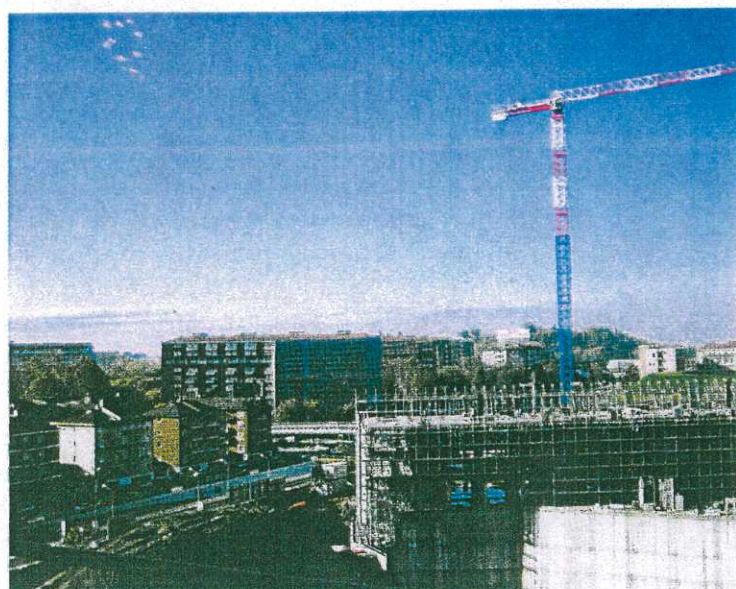
Il panorama del cantiere al Portello
